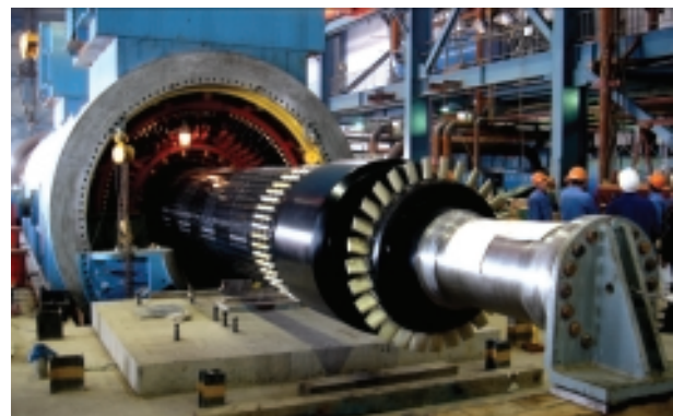
黃驊電力安裝發電機
