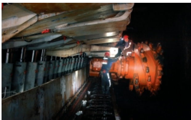
神東礦區補連塔礦長壁開採工作面
